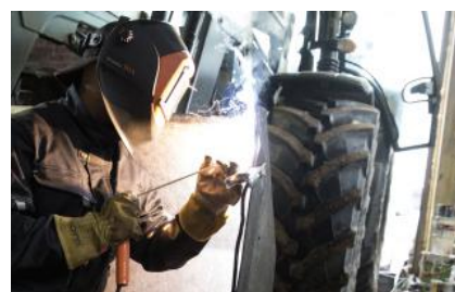
Popravila in vzdrževanje
