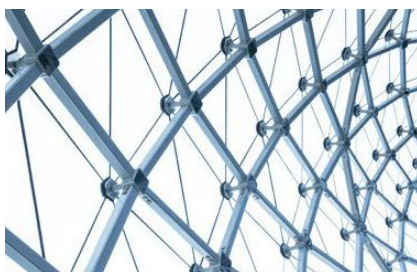
Zahtevne kovinske konstrukcije
