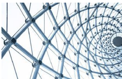
Zahtevne kovinske konstrukcije
